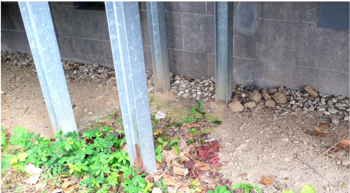
Bild 2, Bsp.: Stahlstützen der Balkonkonstruktion ohne Fußpunkterdung
