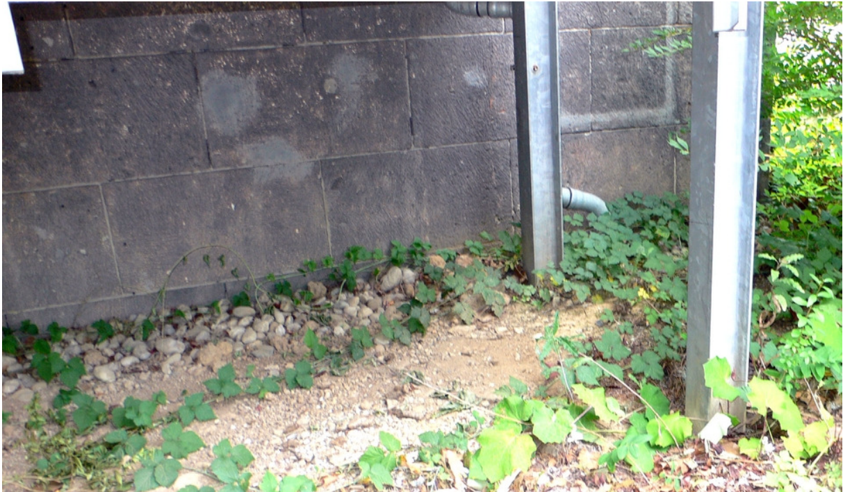
Bild 2, Bsp.: Stahlstützen der Balkonkonstruktion ohne Fußpunkterdung
